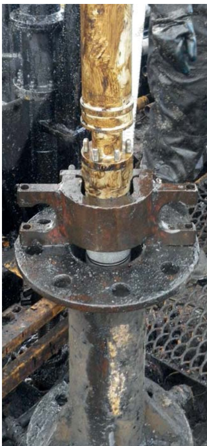
● Photo 4 Tripping operations with the use of the GPN4-50-2000 pump ● Фото 4 Спускоподъемные работы с героторным насосом ГПН4-50-2000 на скважине
